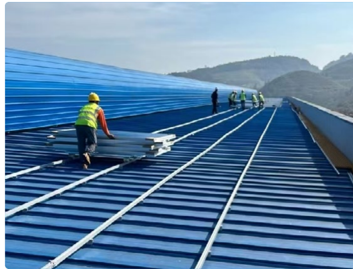
台江光伏电站
